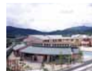
附属幼儿园竣工（1997年）
