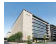
二条校区一号馆竣工（2011年）
